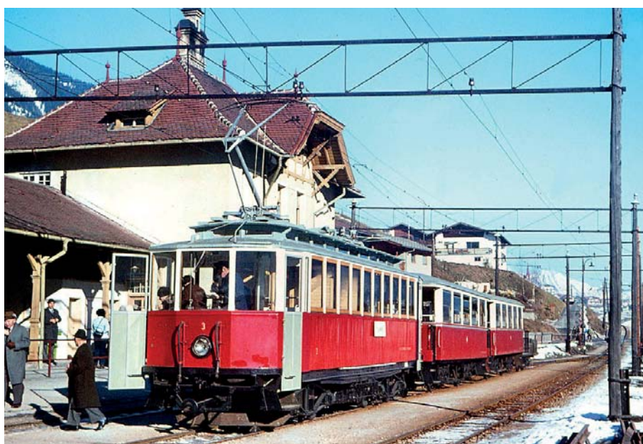
Stubaibahn um 1965. Wichtigstes Transportmittel und Personenzug von Innsbruck nach Fulpmes [Bild: Archiv Gemeinde Fulpmes]
